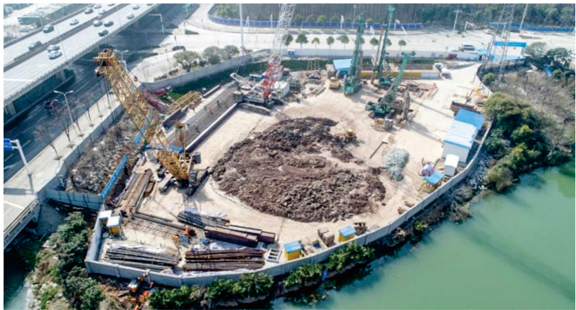
大东湖核心区污水传输系统工程施工现场
