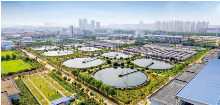
三金潭污水处理厂扩建工程
