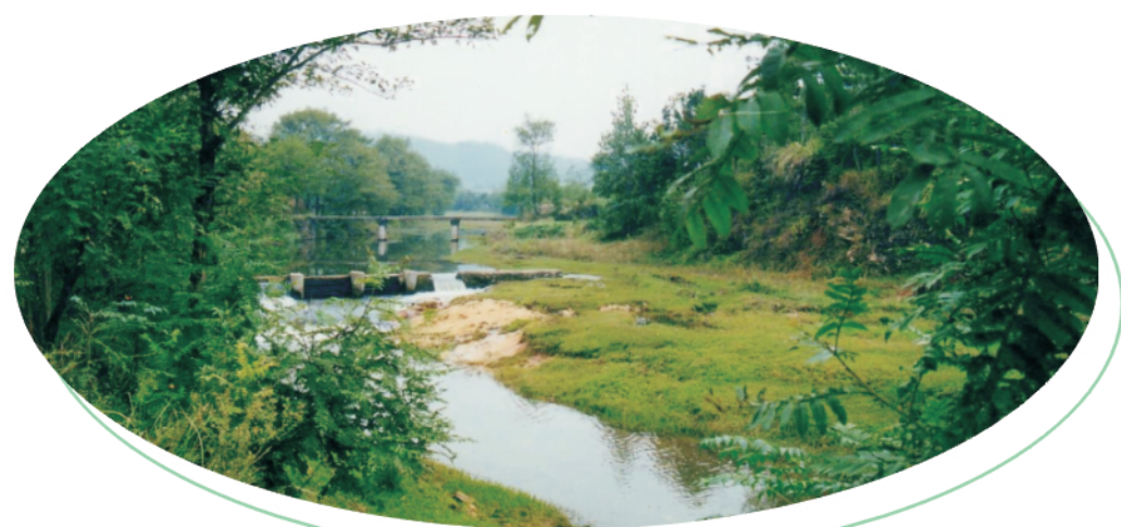
▲ 新洲区周铁河流域拦沙坝
