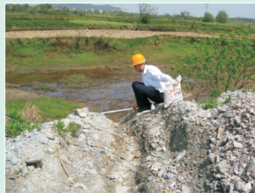
▲ 红岗山隧洞弃渣场排水沟水土保持监测
