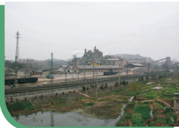
▲ 河床抬高,对铁路安全造成隐患
