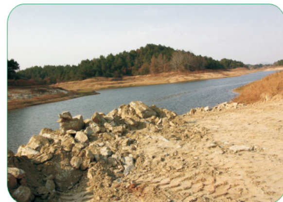
▲ 泥沙淤积水库
