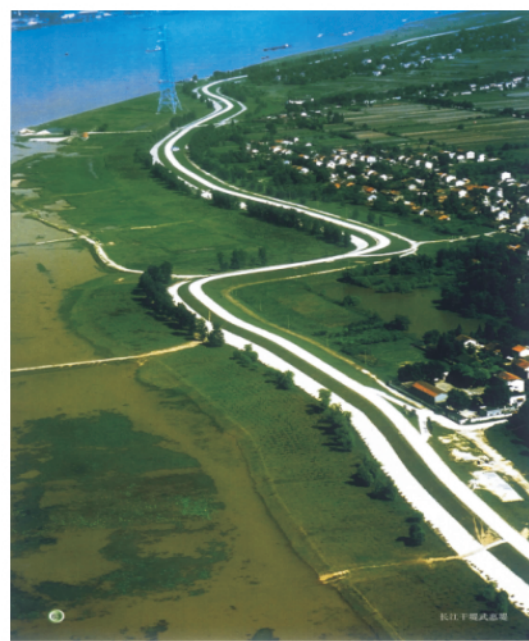
▲ 长江干堤武惠堤水土保持绿化
