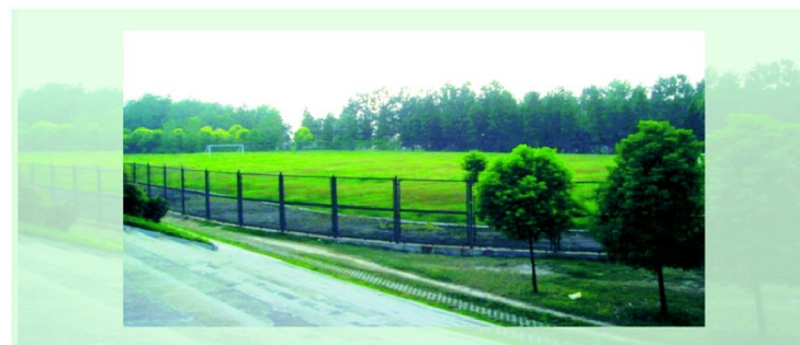
▲ 青山江滩防洪及环境综合整治工程
