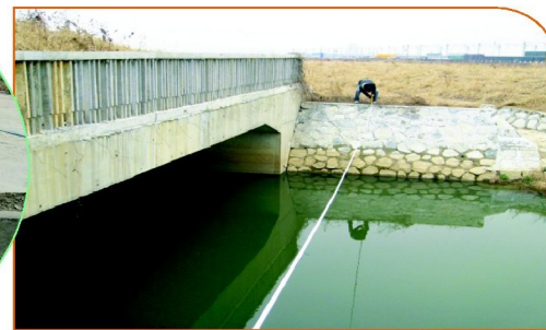
▲ 工作人员对东西湖铁路集装箱中心站项目进行沉砂池法定位监测和渠道断面监测
