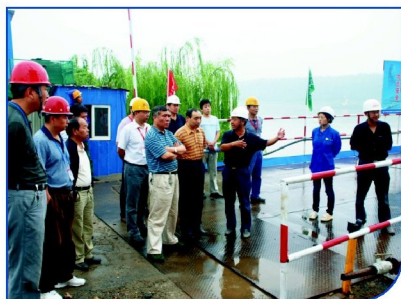
▲ 实地查看汉宜铁路施工过程中水土保持措施落实情况
