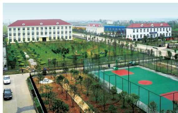
▲ 新建武汉北编组站工程场站绿化
