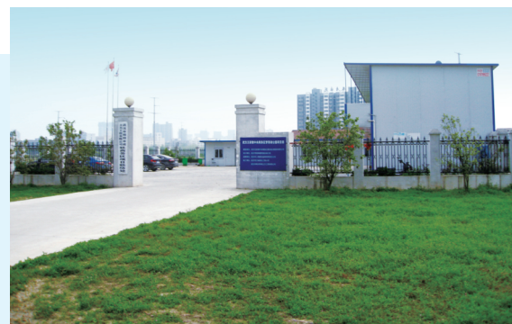
▲ 武汉王家墩中央商务区施工营地绿化
