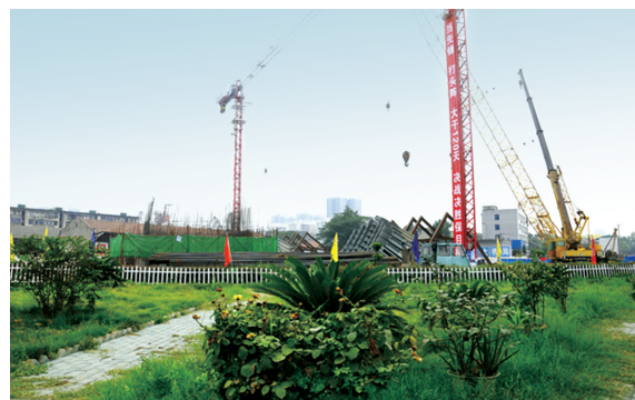
▲ 鹦鹉洲大桥南锚锭花园式工地
