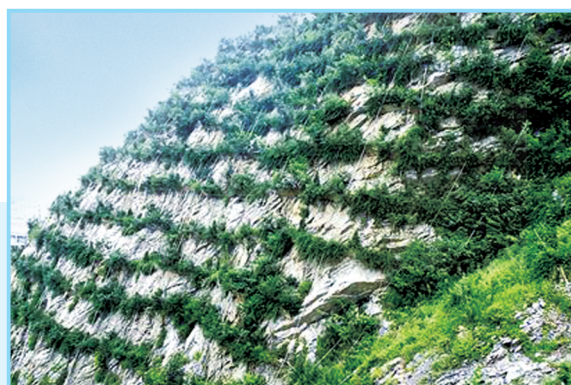
▲ 复绿后的蔡甸区废弃采石山体立面
