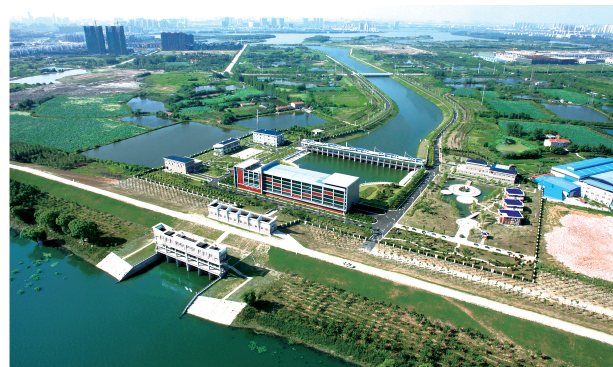
▲ 东西湖区新建白马泾泵站工程全景图
