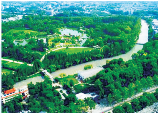
▲ 青山港引水明渠综合治理
