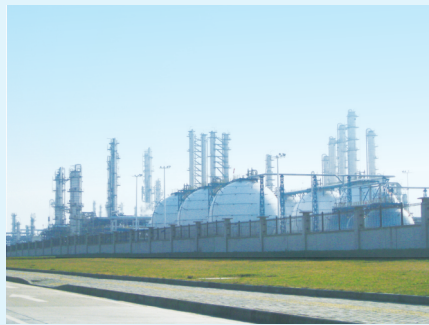
▲ 建成投产后武汉80万吨乙烯工程
