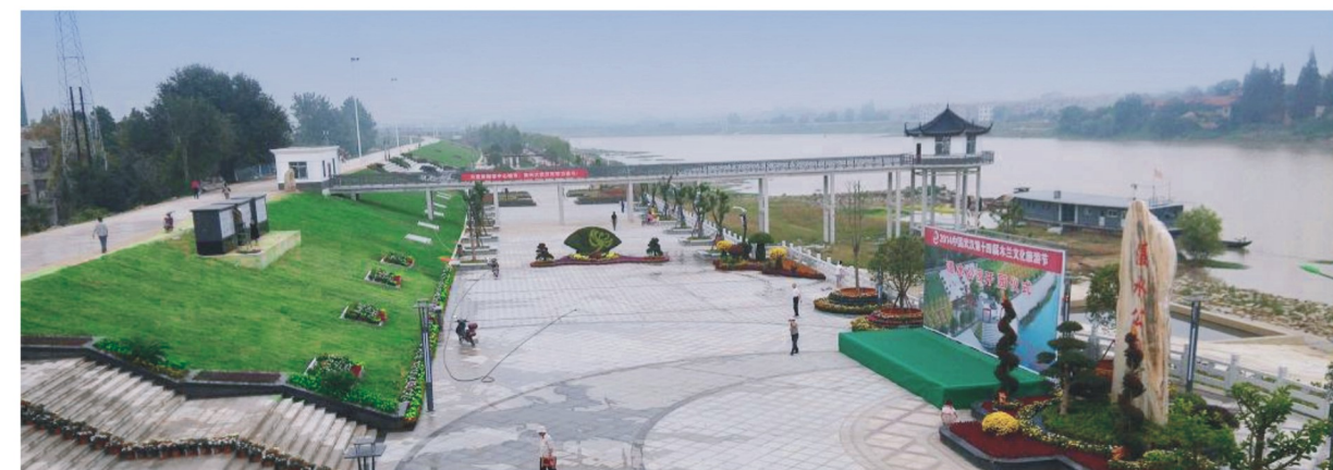
▲ 黄陂区滬水河前川段休闲景观区改造工程（一期）
