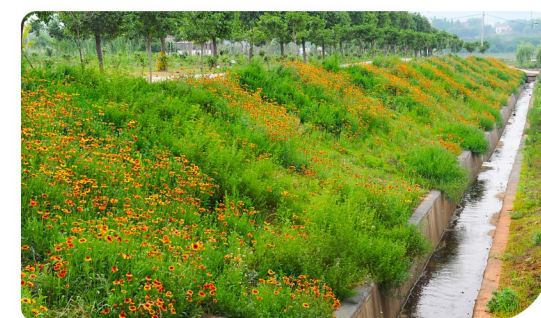
▲ 花卉植物护坡及排水沟
