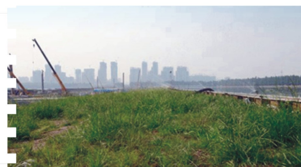
▲东湖通道工程施工围堰落实水土保持植物措施
