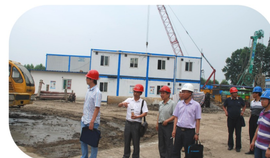
▲市水务局监督检查长江航运中心水保方案落实情况
