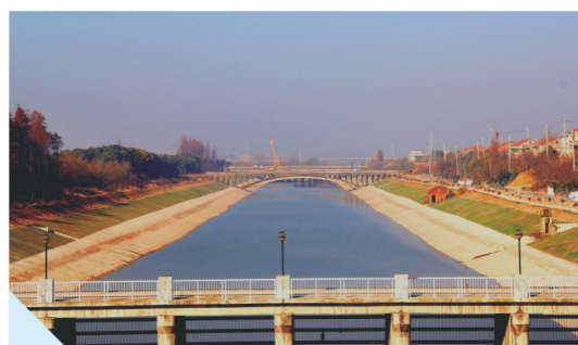
▲ 大军山泵站进水港综合整治
