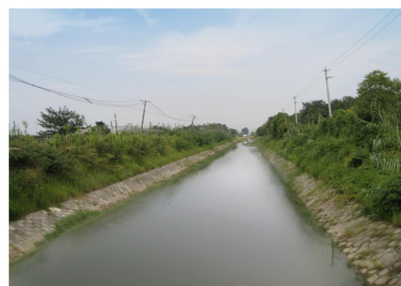
▲ 洪山区青菱乡十里长渠清淤护砌工程
