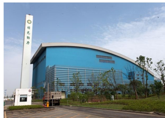
▲ 青山区垃圾焚烧发电工程
