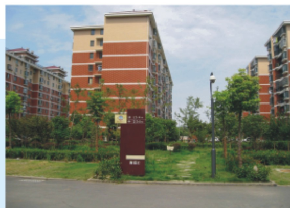
▲ 硚口区汉口·华生城市广场一期工程
