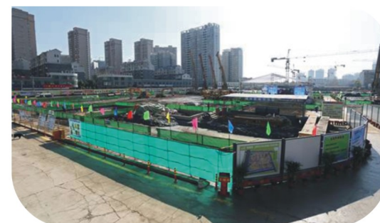
▲江岸区福星惠誉红桥城K3地块施工现场分区管理
