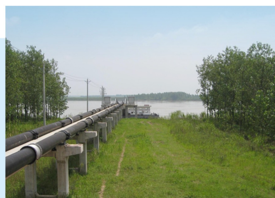
▲ 汉南区新沟补源泵站工程
