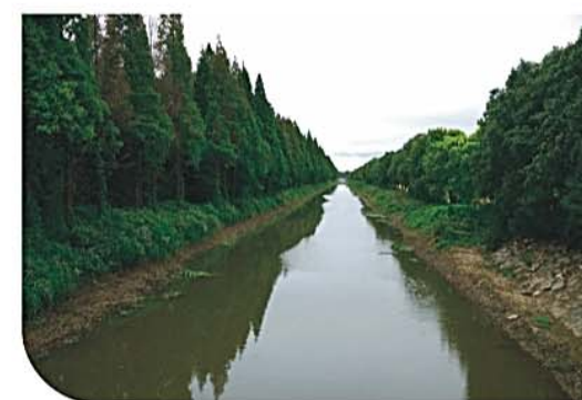
▲ 黄陂区武湖街三排渠综合整治
