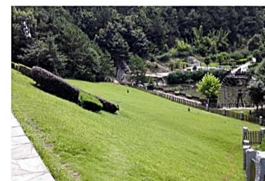
▲ 黄陂区木兰天池景区龙池堰水库除险加固
