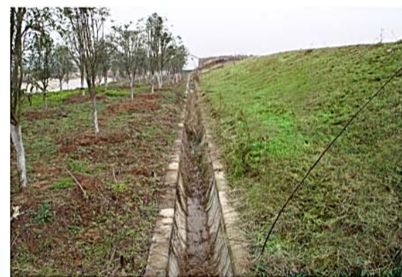
▲ 江夏区关山村小流域水土流失综合治理
