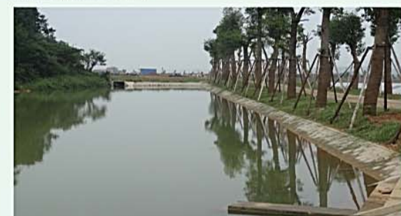
▲ 一号明渠清淤护坡
