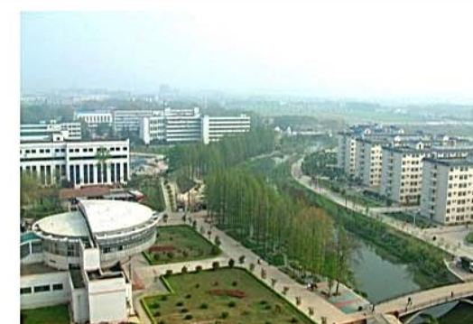
▲ 洪山区巡司河综合整治二期（湖工段）
