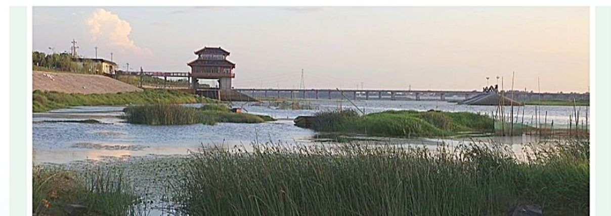
▲ 新洲区举水河橡胶坝
