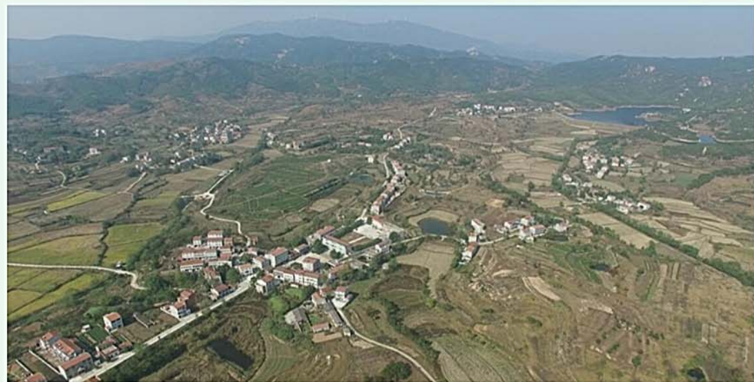
▲ 黄陂区郭岗河小流域整治区现状
