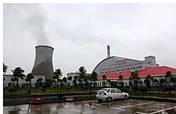
▲ 长山口垃圾焚烧发电改扩建工程水土保持监测
