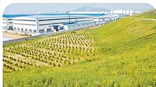
▲ 蔡甸区菱山永安中原矿区治理工程
