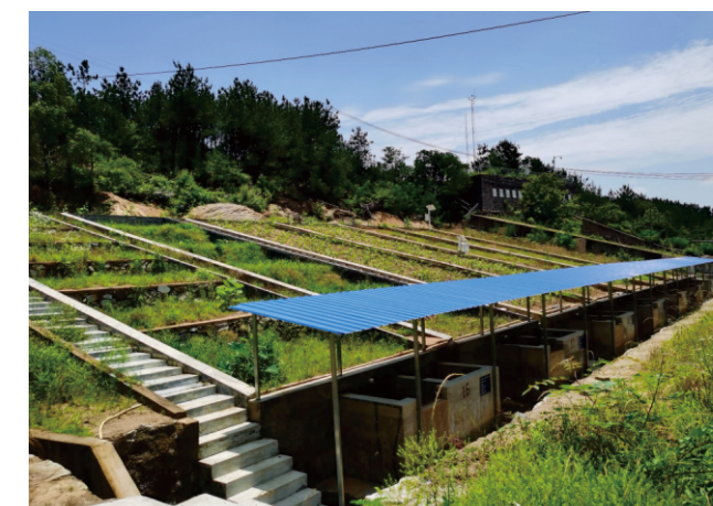
郭岗河流域监测点新建7个标准坡面径流小区全景
