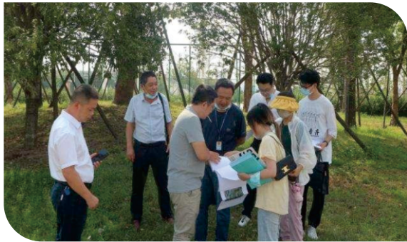
现场检查江滩闸口改造及景观提升工程
