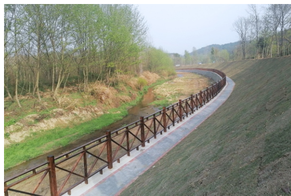
道观河河道岸坡防护治理效果
