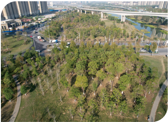
黄家湖大道与三环线交汇节点区域环境综合整治 提升工程完成验收核查
