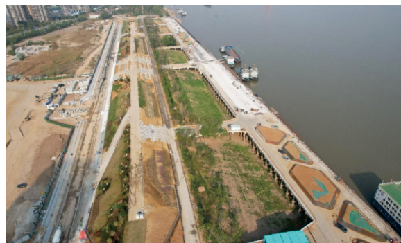
杨泗港都市T台（杨泗港国际集装箱码头段） 连通及景观工程监督性监测
