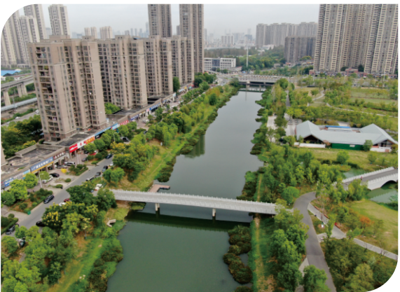
巡司河综合整治工程二期工程完成验收核查
