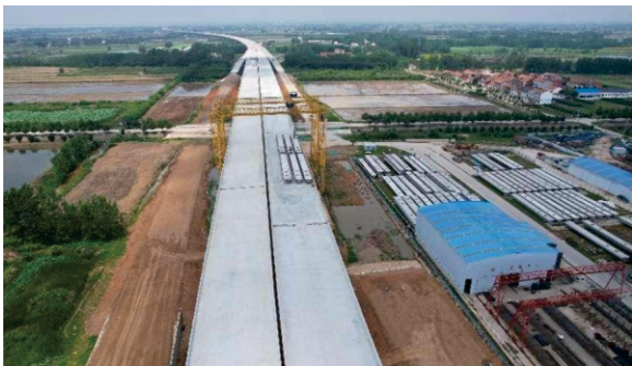
G347武汉市新洲段（内园滩至红岭）改建工程 监督性监测
