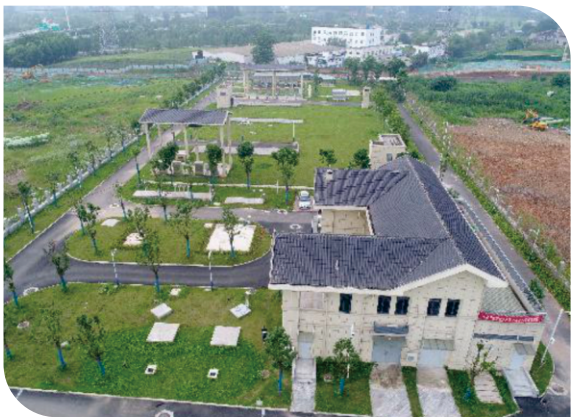
大东湖核心区污水传输系统工程完成验收核查
