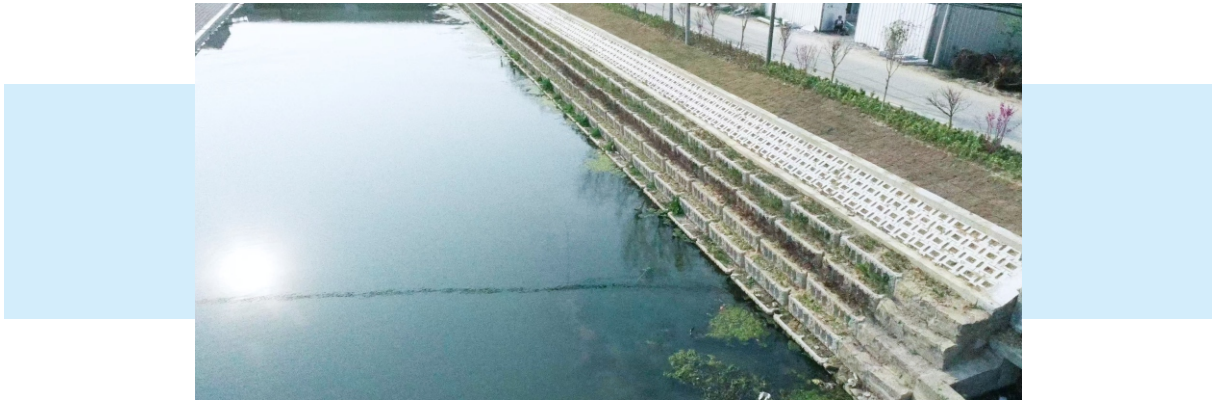
少潭河河道整治生态护岸措施效果
