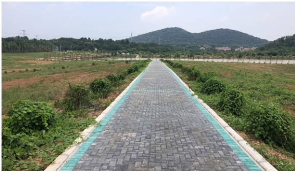
人行道路透水铺装措施效果
